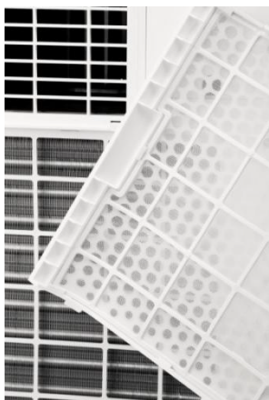
Éteindre l'appareil et retirer les deux filtres à air.
